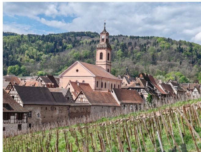
L'enceinte de Riquewihr, côté nord.
