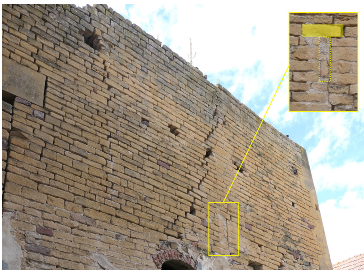
Fig.4 : Façade est. En jaune une des ouvertures en fentes conservées. (crédit : C. Heym).
