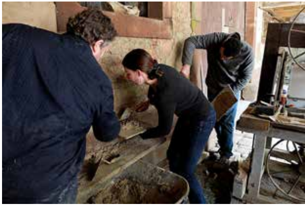
Stage d'enduit à la chaux.
