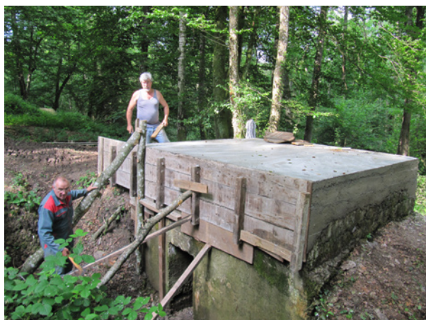
Restauration du toit d'un avant-poste allemand du front de la Largue, juin 2012. Photo André Dubail.
