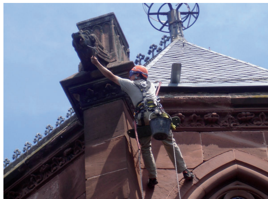
L'entreprise ETAD à l'oeuvre
