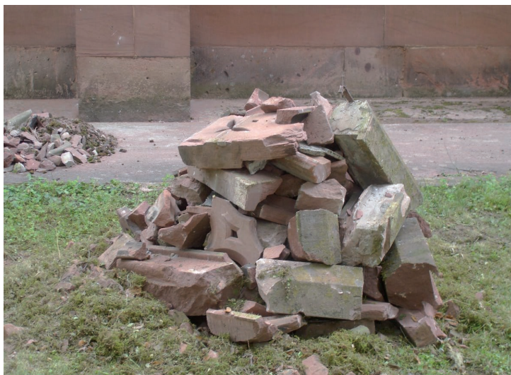
Les éléments sculptés mis en tas avant départ à la décharge
