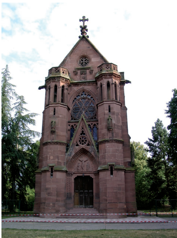
Façade nord de la chapelle avec sa croix sommitale
