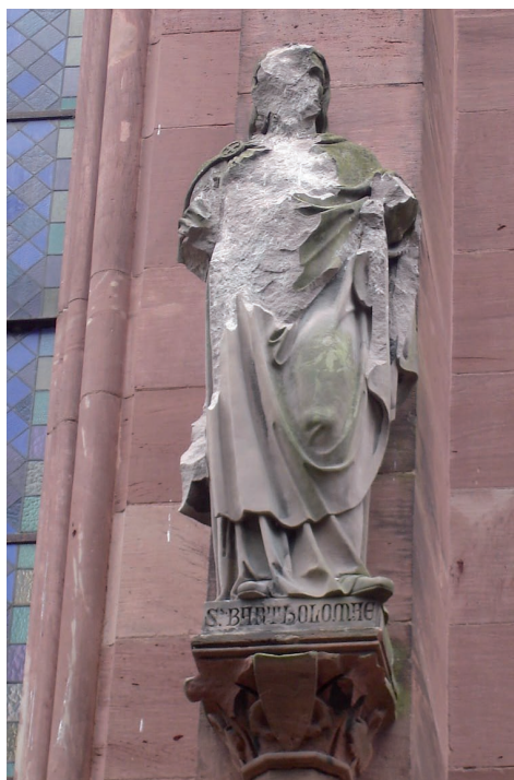
La statue de saint Bartholomée après les travaux
